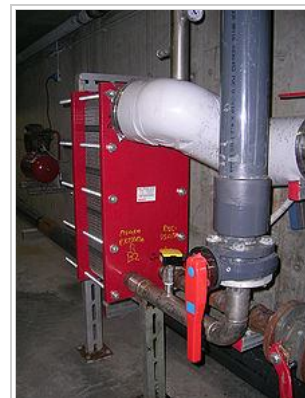
Un intercambiador de calor de placas intercambiables aplicada al sistema de una piscina
